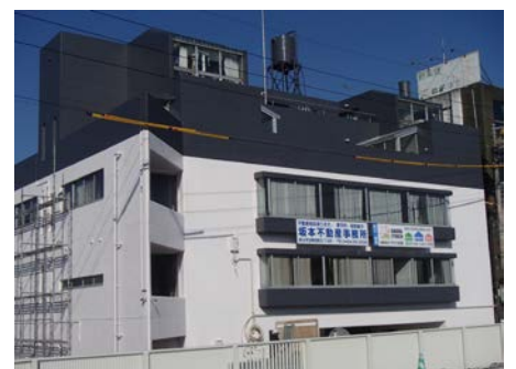
全面改修工事と看板取付事例
