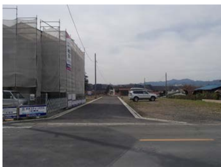
給排水設備を引き込んだ分譲地
