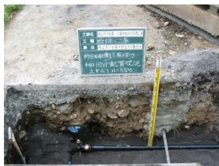
分譲地に給水管を引き込む様子
