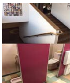
既存のトイレ
