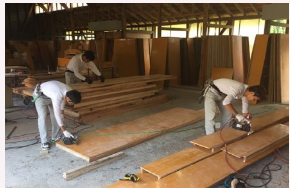
型枠加工の様子
